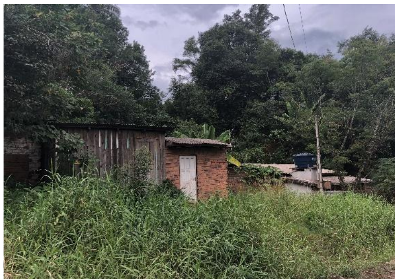
Figura 8 - Pequeno terreno com habitação de baixa renda, localização na Rua 13 de maio
