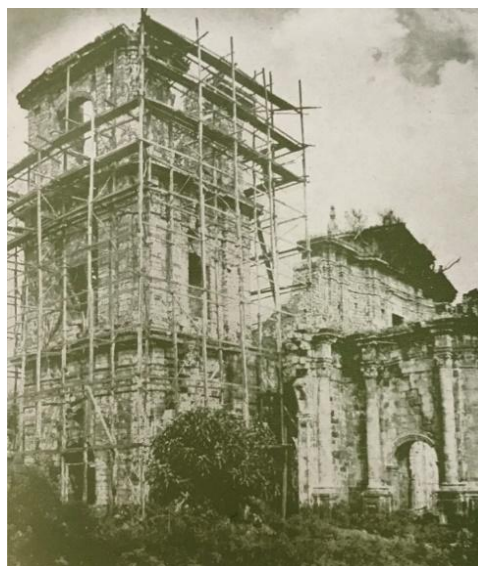
Figura 7 - Escoramento da fachada da Igreja de São Miguel pela Dtc
