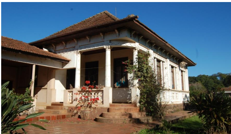
Imagem 11 - Vista atual da residência de 1935
