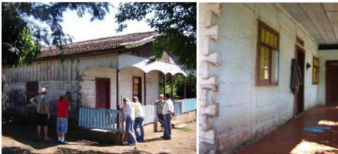
Figura 11 - Casa em Guarani das Missões construída sem o uso de pregos, apenas encaixes
