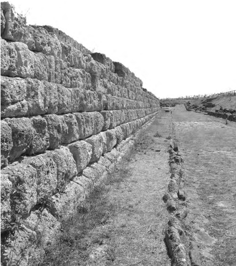
Fig. 2 - Tempio dell'Ara della Regina: il monumentale basamento realizzato in opera quadrata di blocchi di pietra di macco. Un canale in masselli di pietra, destinato alla regimentazione delle acque meteoriche, costeggia ordinatamente la poderosa struttura di sostruzione.
