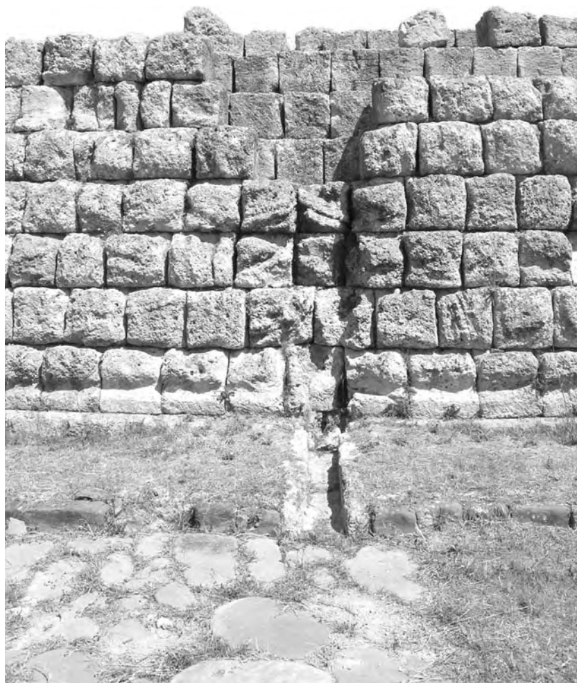
Fig. 3 - Tempio dell'Ara della Regina: sul basamento compare un'apparecchiatura muraria per il convogliamento, raccolta e scarico delle acque meteoriche.
