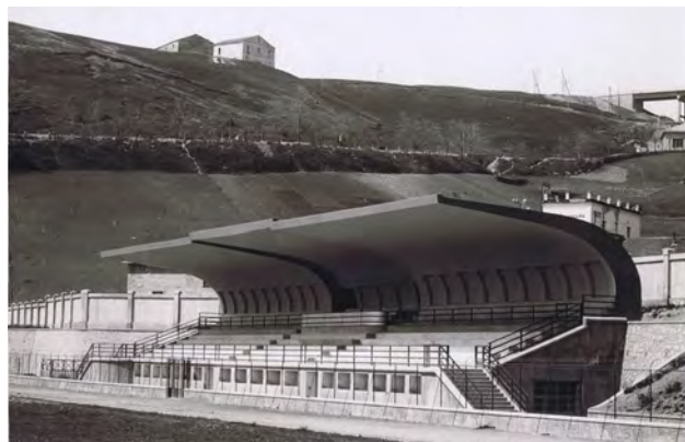
Potenza, Campo Sportivo Littorio, 1935, veduta della tribuna centrale coperta (Archivio privato Laurini, per gentile concessione dell'ing. Salvatore Laurini).
