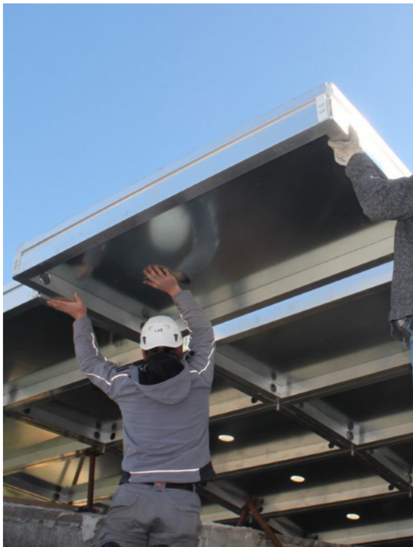
Fig. 3. Installazione dei moduli tetto dell'azienda MAS Roof.
