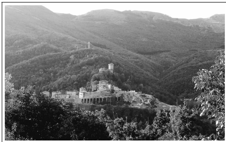
Figura 6 – Arquata del Tronto, capoluogo: danneggiamenti a seguito del sisma.
