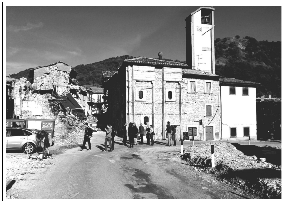
Figura 8 – Arquata del Tronto, frazione di Pretare: danneggiamenti a seguito del sisma.
