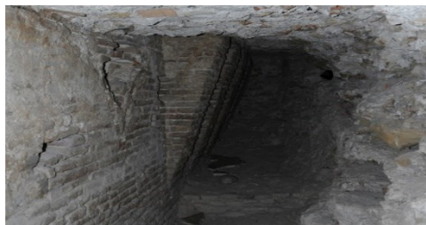
Fig. 4- Cortine laterizie a piombo con beccatelli, ritrovate nel corso dei lavori di restauro
