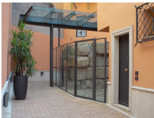
Fig. 6. Resti di mura serviane nel cortile di un edificio privato nel quartiere Esquilino, Roma (foto Ercolino 2018).
