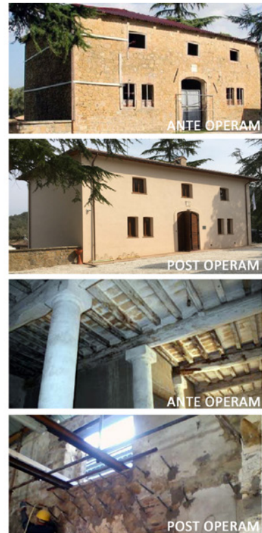
Fig. 5. Ex Scuderie della Rocca di Sant'Apollinare: l'intervento, certificato oro, è ritenuto altamente performante, a discapito però dell'impatto sul costruito: si noti come di fatti alla categoria 'Valenza storica' sia stato assegnato il minore punteggio, con soli 3 punti su 20 (LEED GBC ITALIA 2018).
