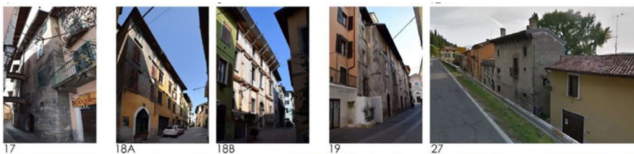
Fig. 2. Comune di Salò (BS): a) esempio di valutazione speditiva di vulnerabilità sismica del comparto 1 (centro storico) attraverso i dati della Scheda CARTIS; b) alcuni esempi di edifici con diverse classi di vulnerabilità (OGGIONI, PAGANI 2017).
