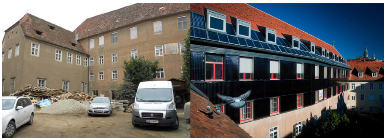
Fig. 6. Foto del Franciscan Monastery (Graz, Austria), prima e dopo l'installazione di una pannellatura fotovoltaica sulla facciata. Progettata per ottenere una riduzione dei consumi energetici del 90%, essa tuttavia tralascia il forte impatto visivo e materico sul costruito storico (SHC IEA < https://www.iea-shc.org/ >).
