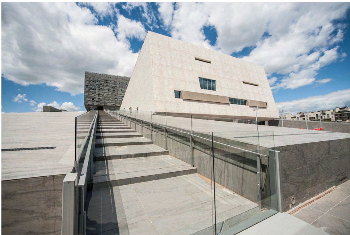
7. Rampe esterne (foto Raniero Carloni).
