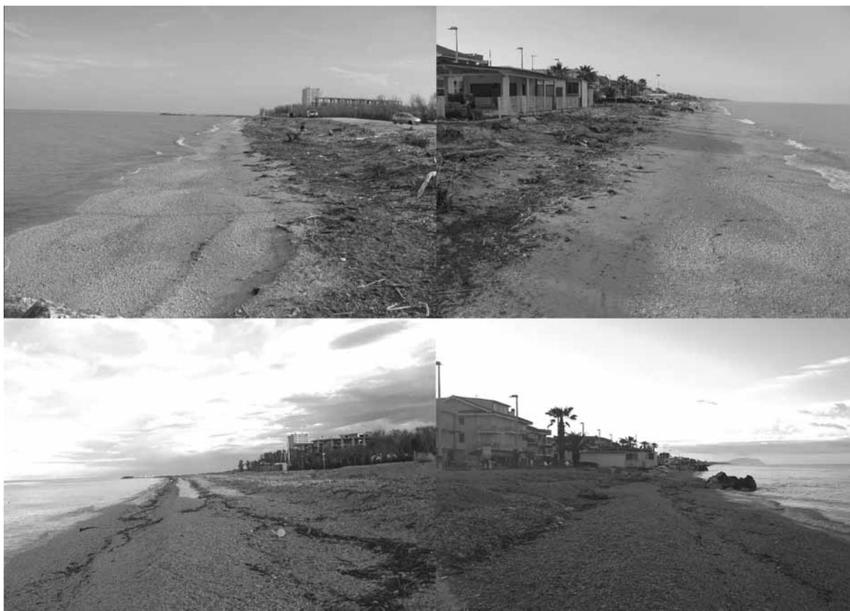
**Figura 5.** Fenomeni erosivi in atto sulla spiaggia posta immediatamente sottoflusso al pennello realizzato nel 2006/07 in sponda sinistra alla foce del Fiume Tenna (verso sud a sinistra, verso nord a destra, in alto marzo 2011, in basso maggio 2015).
