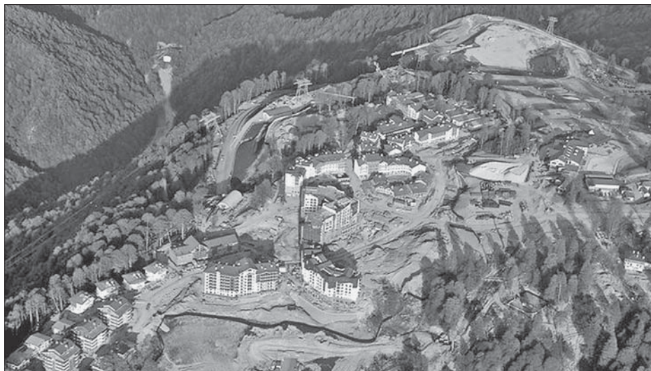
FIG. 10 CONSTRUCTION WORKS IN ROSA KHUTOR, SOCHI SL. 10. IZGRADNJA NA LOKALITETU ROSA KHUTOR, SOCI
