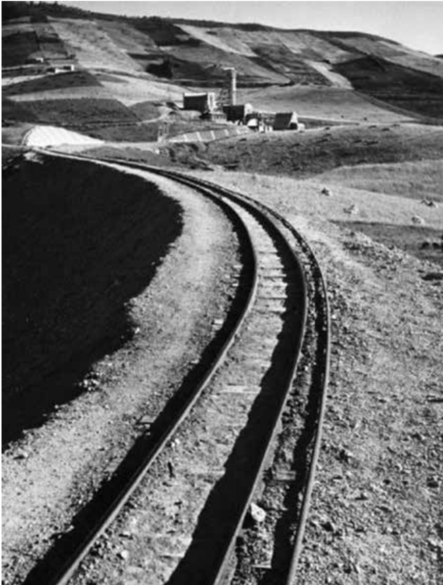
Fig. 1: Grottacalda Sulphur Mine (1940). Railway and Headgear Structure. Ufficio Fotografico Montecatini. Available from: http://www.lombardiabeniculturali.it/fotografie/schede/IMM-3h030-0001006/ . [ Accessed: 09th April 2015].
