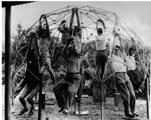
01 Buckminster Fuller con alcuni studenti del Black Mountain College durante un test di resistenza della cupola geodetica (estate 1949). Fonte State Archives of North Carolina and Black Mountain College Museum
