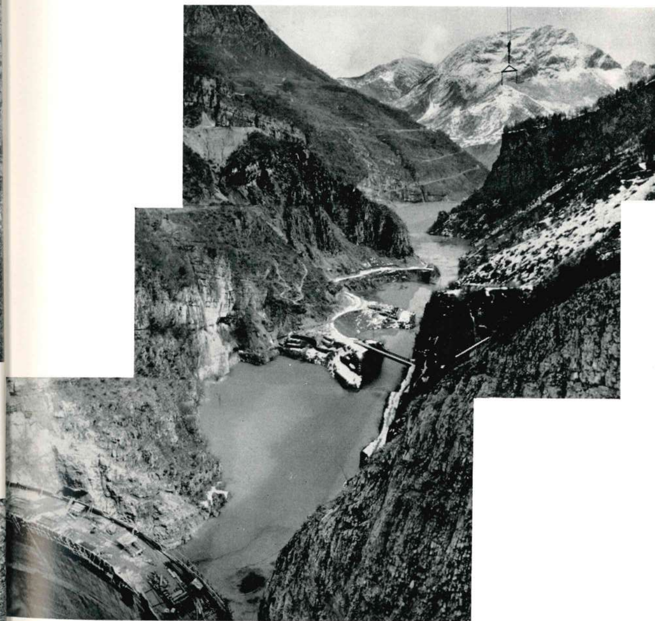
Fig. 7 - marzo 1960 - La valle del Vaiont a monte della diga, ancora in costruzione, con invaso parziale (q. 600 circa). Si vedono il ponte del Colomber e la vecchia strada in basso, e in alto la nuova strada. Tra le due strade, in corrispondenza al restringimento più orientale della valle, si vede la massa scollata e frantumata e con giacitura anormale, che attualmente, dopo lo scivolamento, forma il « Colle Isolato ». Una massa dello stesso tipo, ma molto più piccola, si può intravedere, sempre sopra la strada vecchia, in corrispondenza al secondo restringimento della valle. La presenza delle tre « quinte » e di depositi ghiaiosi stratificati alla base delle masse scollate, hanno permesso l'ipotesi che le masse stesse erano scivolate, scondo lo scrivente da Sud, entro un antico alveo del Vaiont.
