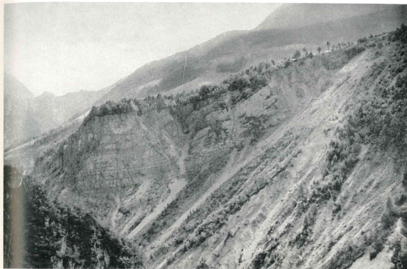
Fig. 4 - Settembre 1959 - La « Punta del Toc », vista dal fianco destro: si notano, verso sinistra nella parete, alcune delle fratture aperte in alto di cui si parla nel testo. In primo piano il pendio dove si è verificata in seguito la frana del 4 novembre 1960.
