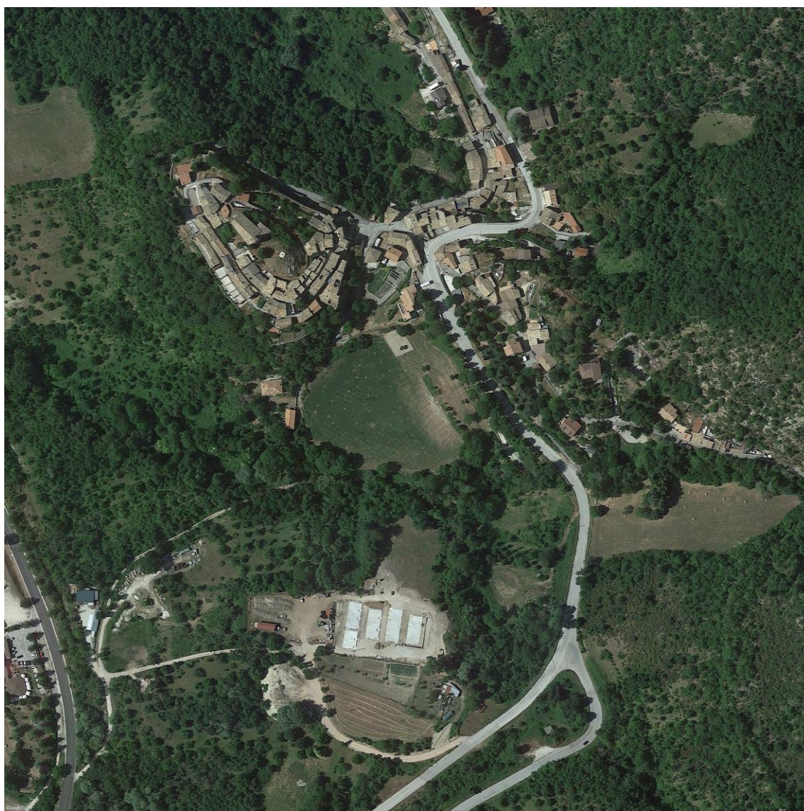
Figura 258. Area SAE "Loc. Appennino", Pieve Torina (MC). Totale numero SAE nell'area 14. Vista satellitare di luglio 2017 con l'area in costruzione, in evidenza le piattaforme di fondazione delle "casetta".
