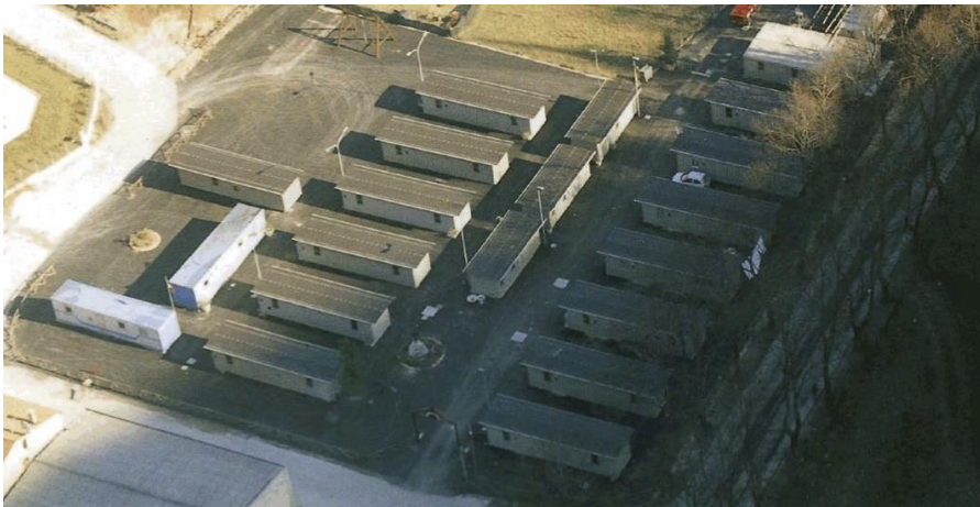
Figura 120. Area adibita a containers abitativi di emergenza nel 1997.
