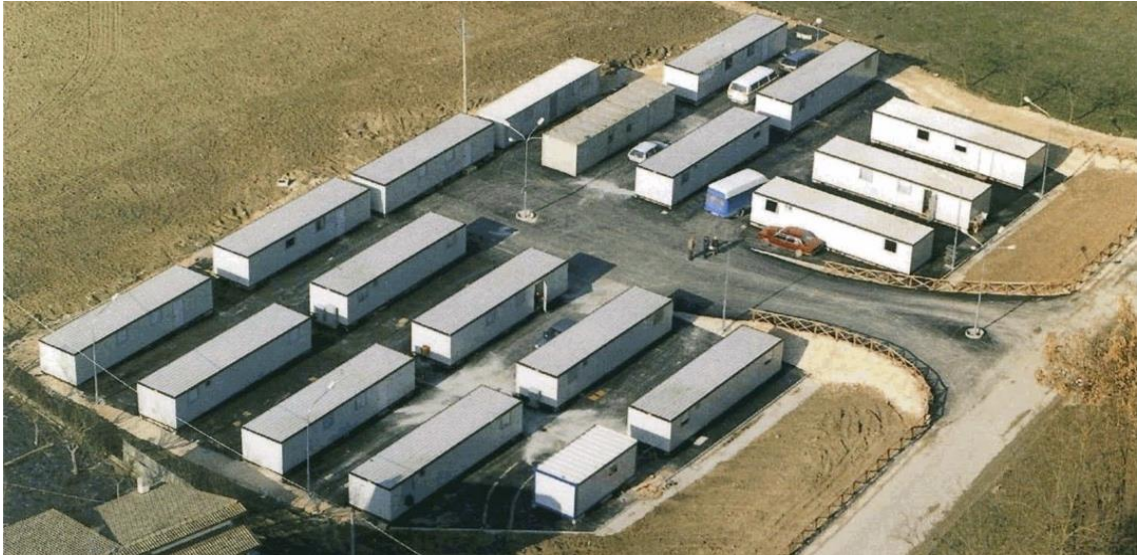
Figura 145. Insediamento d'emergenza per gli sfollati del terremoto del 1997.
