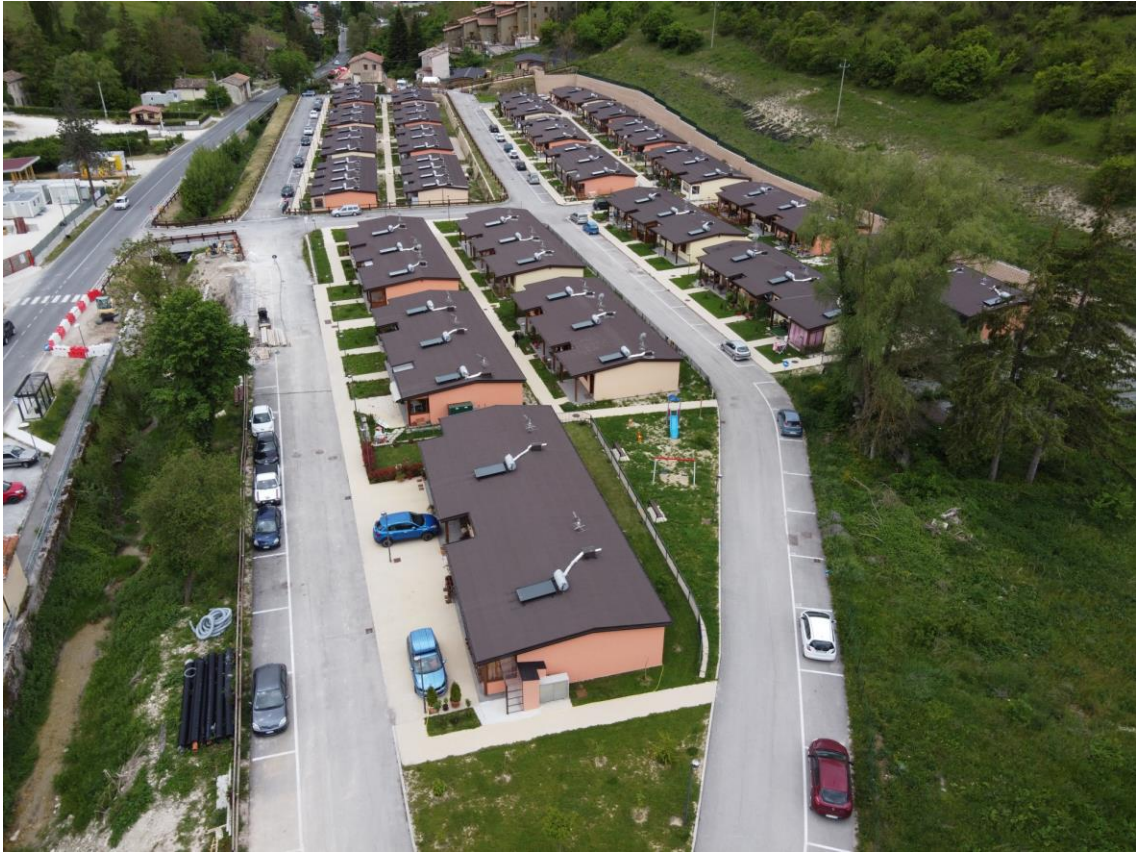
Figura 115. Vista aerea dell'area SAE "Villa Sant'Antonio".
