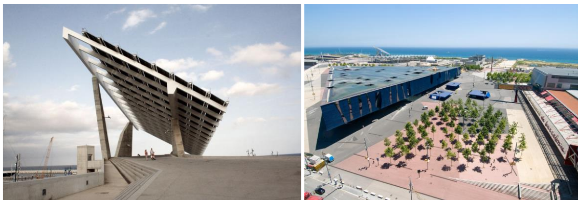
Figura 240. A sinistra: pensilina fotovoltaica. A destra: l'edificio di Herzog e De Meuron.
