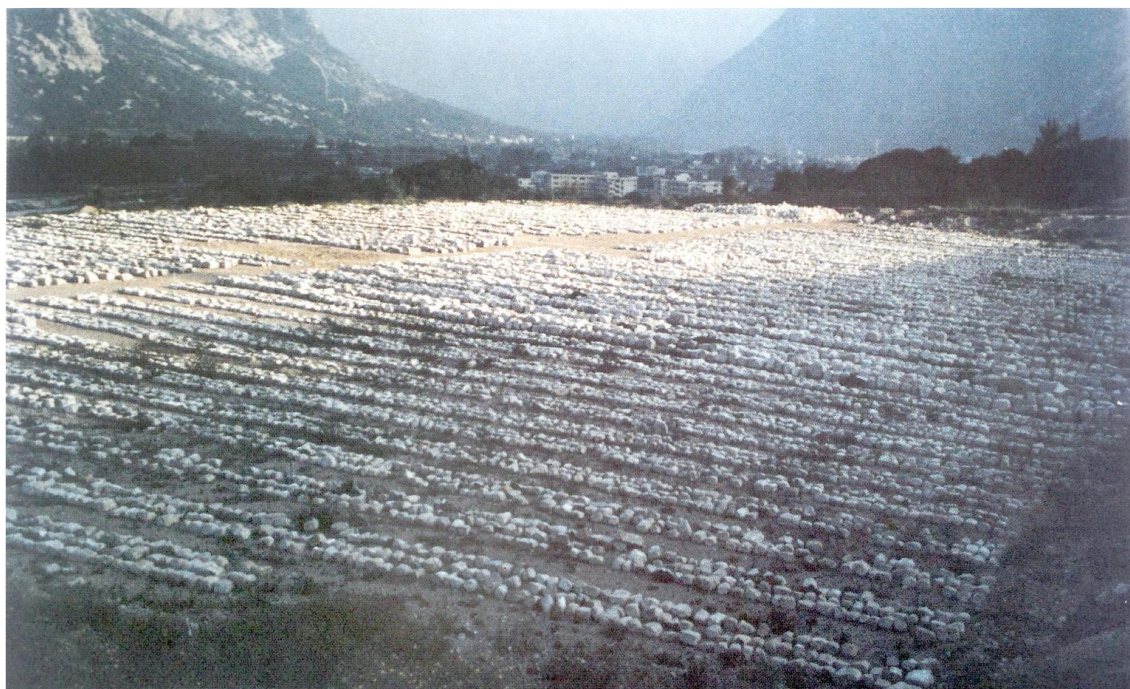
Figura 21. Pietre del Duomo di Venzone depositate a Rivoli bianchi e classificate per posizione e funzione costruttiva, Archivio Duomo di Venzone.
