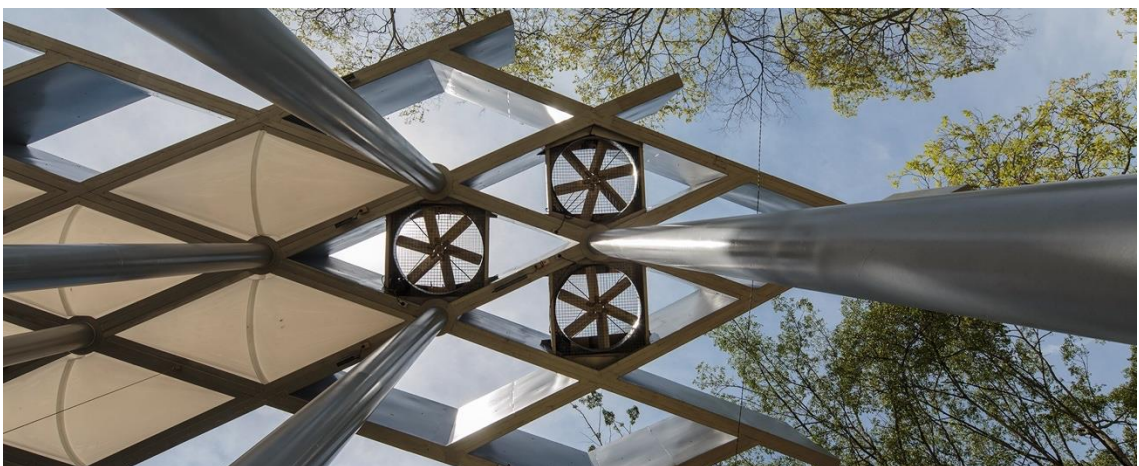
Figura 252. Dettaglio della copertura con i ventilatori alloggiati tra le travi a losanghe.
