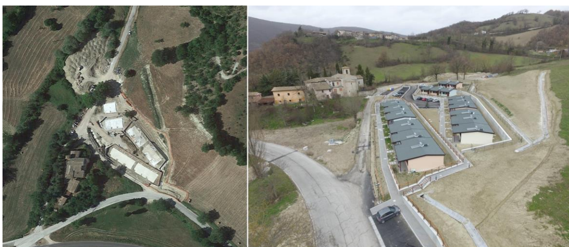
Figura 257. Area SAE " Loc. Casavecchia", Pieve Torina (MC). Totale numero SAE nell'area 17. A sinistra: Vista satellitare di luglio 2017 con l'area in costruzione, in evidenza le piattaforme di fondazione delle "casetta". A destra: vista aerea dell'insediamento completato.
