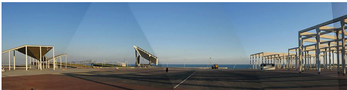
Figura 239. Vista della superficie a patchwork della grande Esplanada con la pensilina fotovoltaica..
