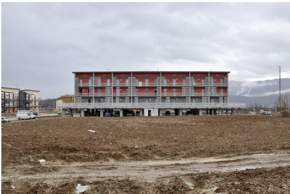
Figura 58. Coppito, frazione de L'Aquila. Progetto CASE "Coppito 3".
