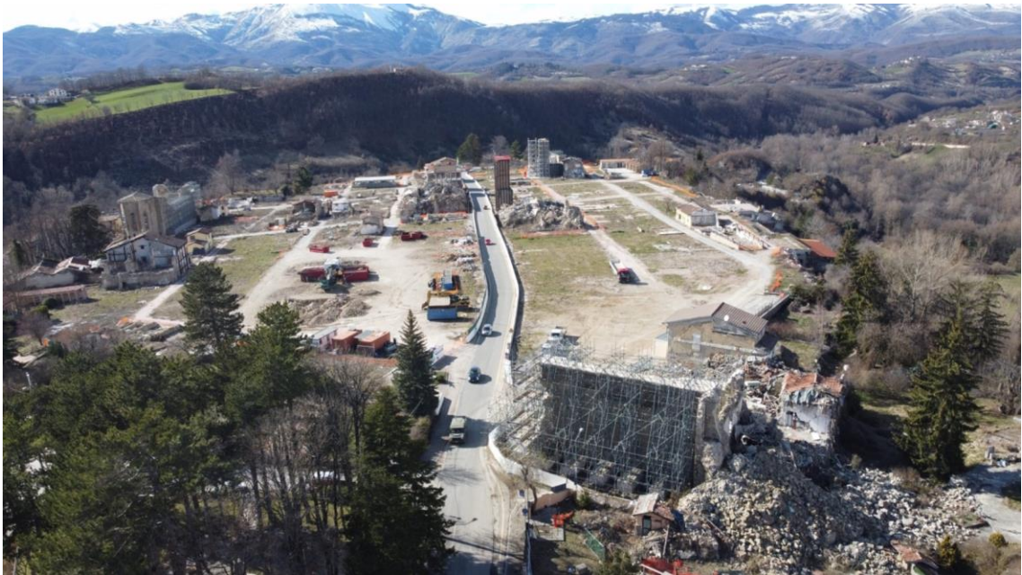
Figura 64. Il centro storico di Amatrice nel 2020 dopo la demolizione degli edifici pericolanti e la rimozione dei detriti del terremoto del 2016-17.
