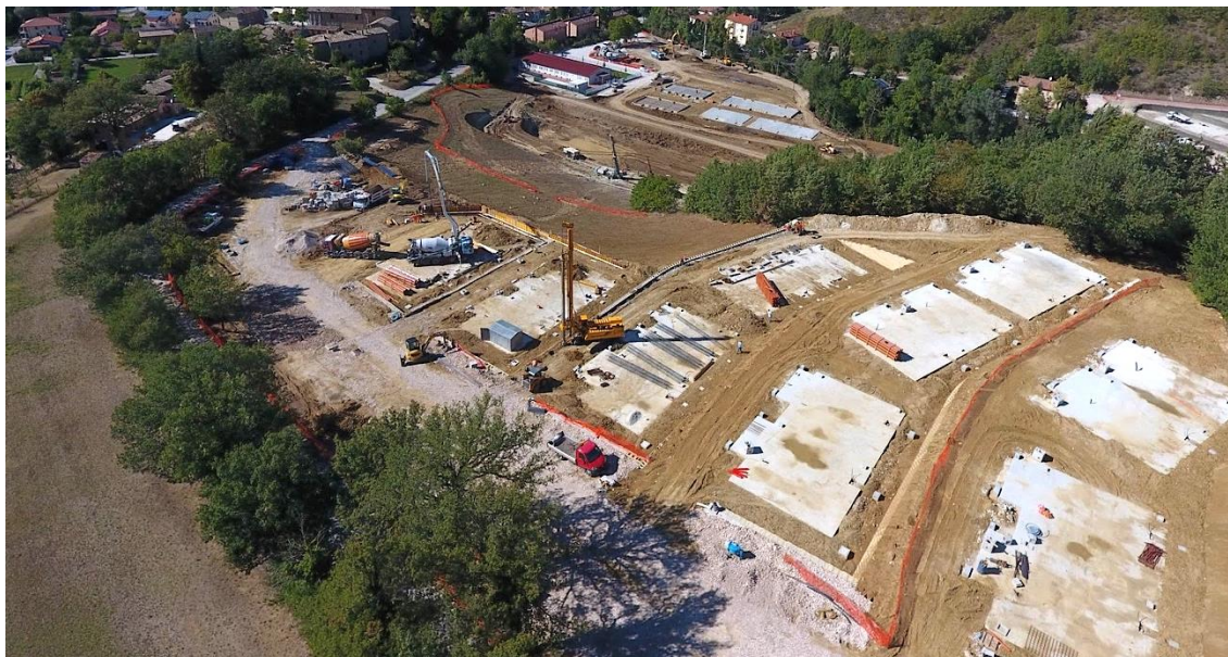
Figura 6. Cantiere area SAE con in evidenza le fondazioni delle abitazioni temporanee, 2017.
