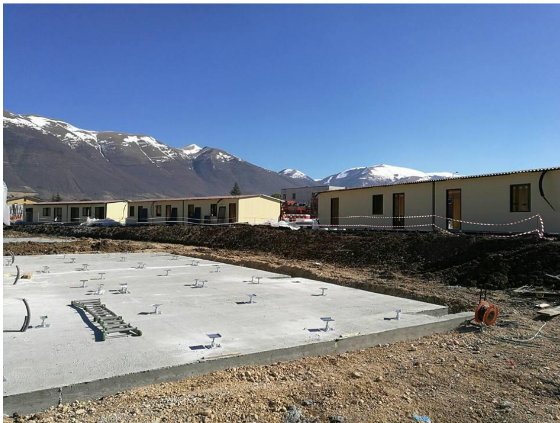
Figura 73. In primo piano, piattaforma di fondazione delle aree Sae. Norcia (PG).
