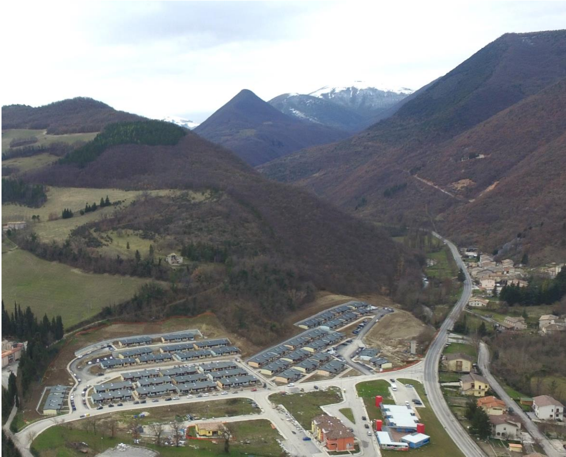
Figura 140. Vista aerea dell'area SAE "Loc. Le Piane Lott.Rosi".
