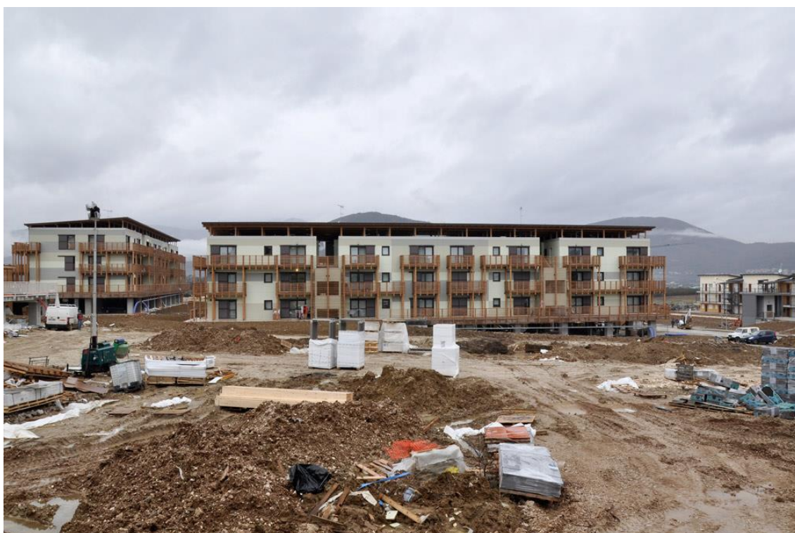
Figura 59. Coppito, frazione de L'Aquila. Progetto CASE "Coppito 3".
