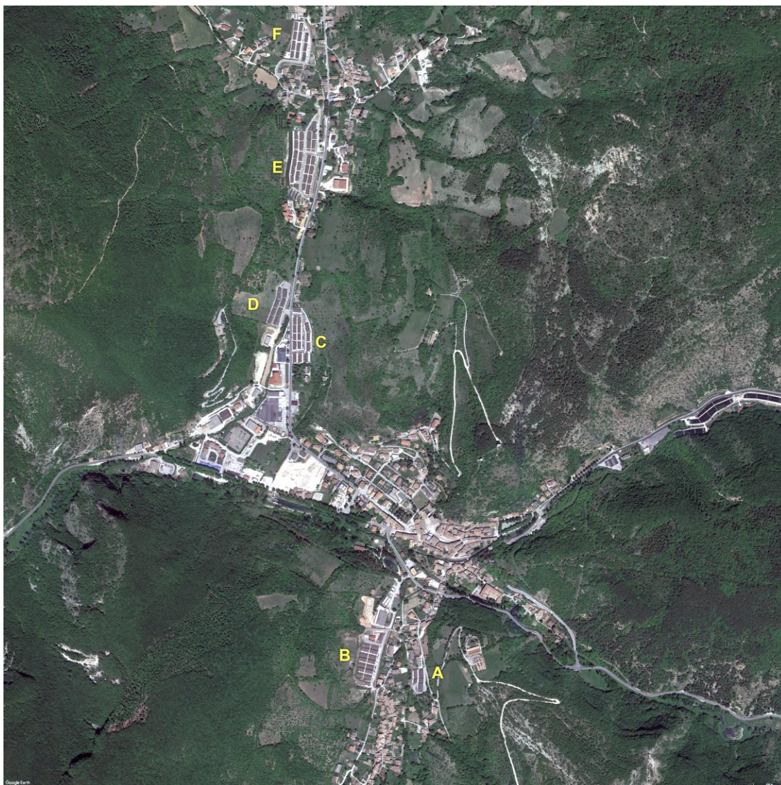
Figura 113. Visso (MC), planimetria con individuazione delle 6 aree SAE: A) “Borgo San Giovanni 1”, totale unità 12; B) “Borgo San Giovanni Campo Sportivo”, totale unità 42; C) “Via C. Battisti 1”, totale unità 46; D) “Via C. Battisti 2”, totale unità 20; E) “Villa S. Antonio”, totale unità 70; F) “Villa S. Antonio 2 Pretara”, totale unità 33.
