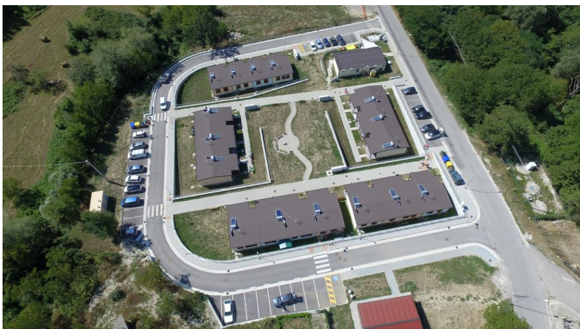
Figura 91. Vista aerea dell'insediamento temporaneo di "Piedilama", totale Numero SAE nell'area 16.
