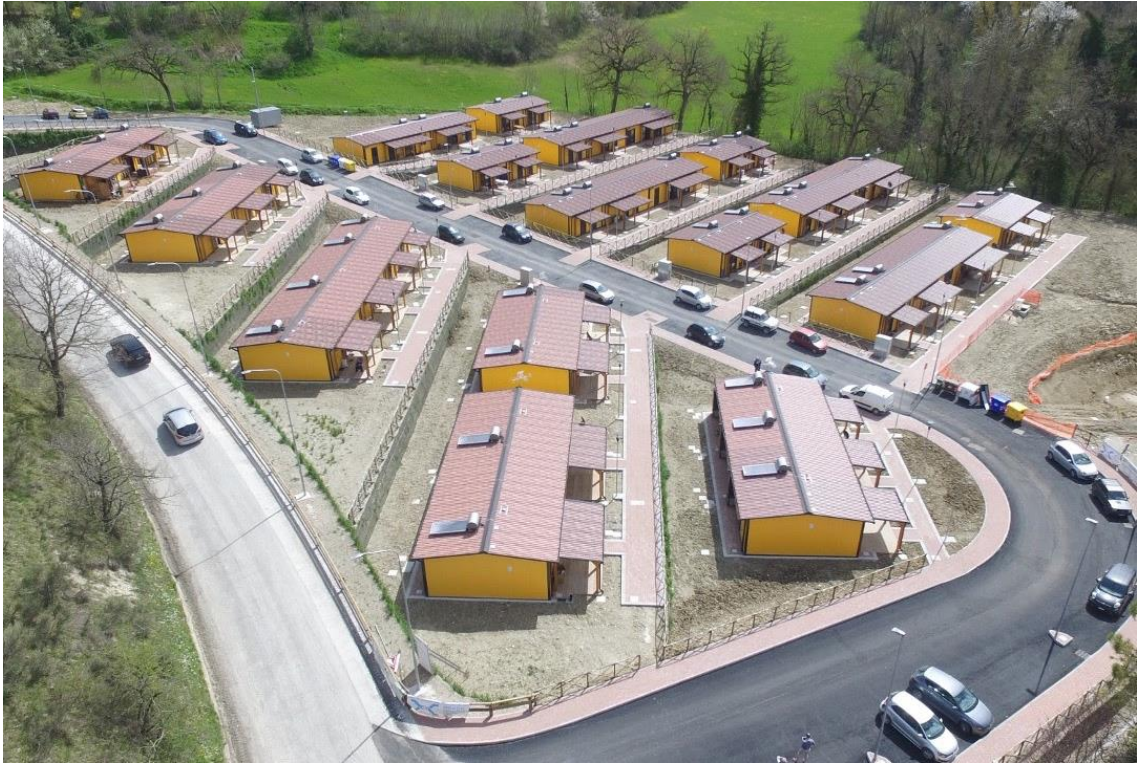
Figura 149. Vista aerea dell'area SAE "Giovanni XXIII".
