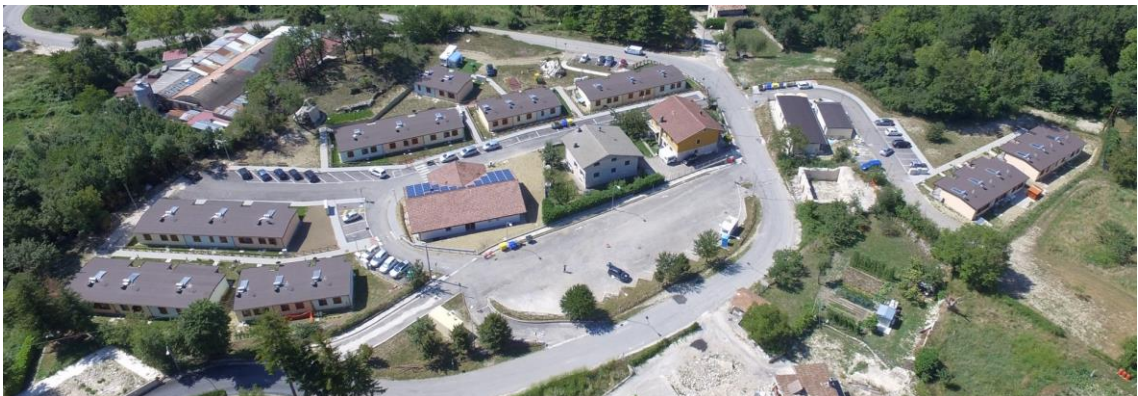
Figura 89. Vista aerea dell'insediamento temporaneo di "Pretare", totale Numero SAE: 26.
