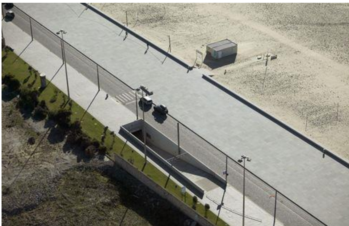
Figura 235. Faixa Marginal di Matosinhos Sul. Vista aerea dell'ingresso al parcheggio interrato.
