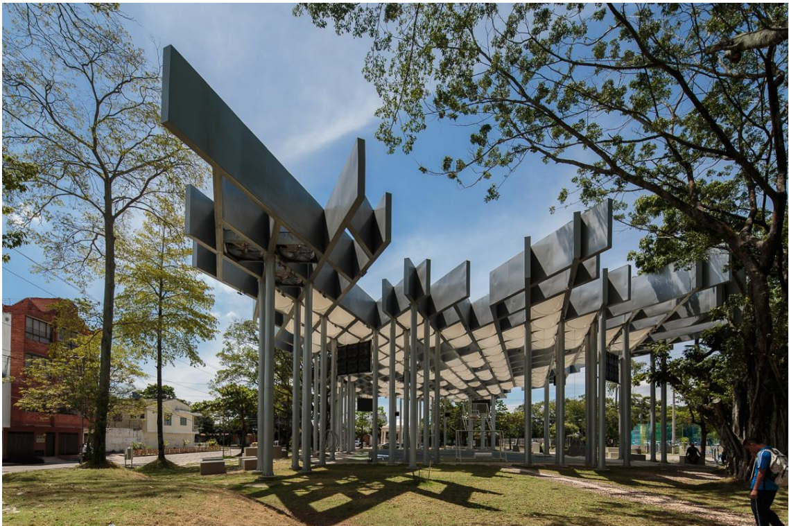
Figura 254. Bordo della tettoia con i caratteristici profili sfrangiati, simbolo di possibile reiterabilità.
