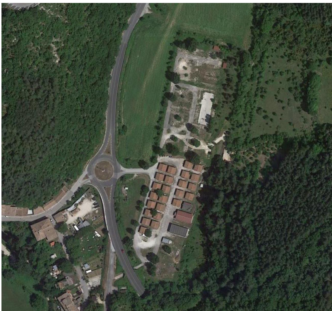
Figura 32. Casenove, Foligno (PG): la situazione attuale a più di vent'anni dal terremoto. In basso le casette in legno, in alto i residui dell'area dei containers.
