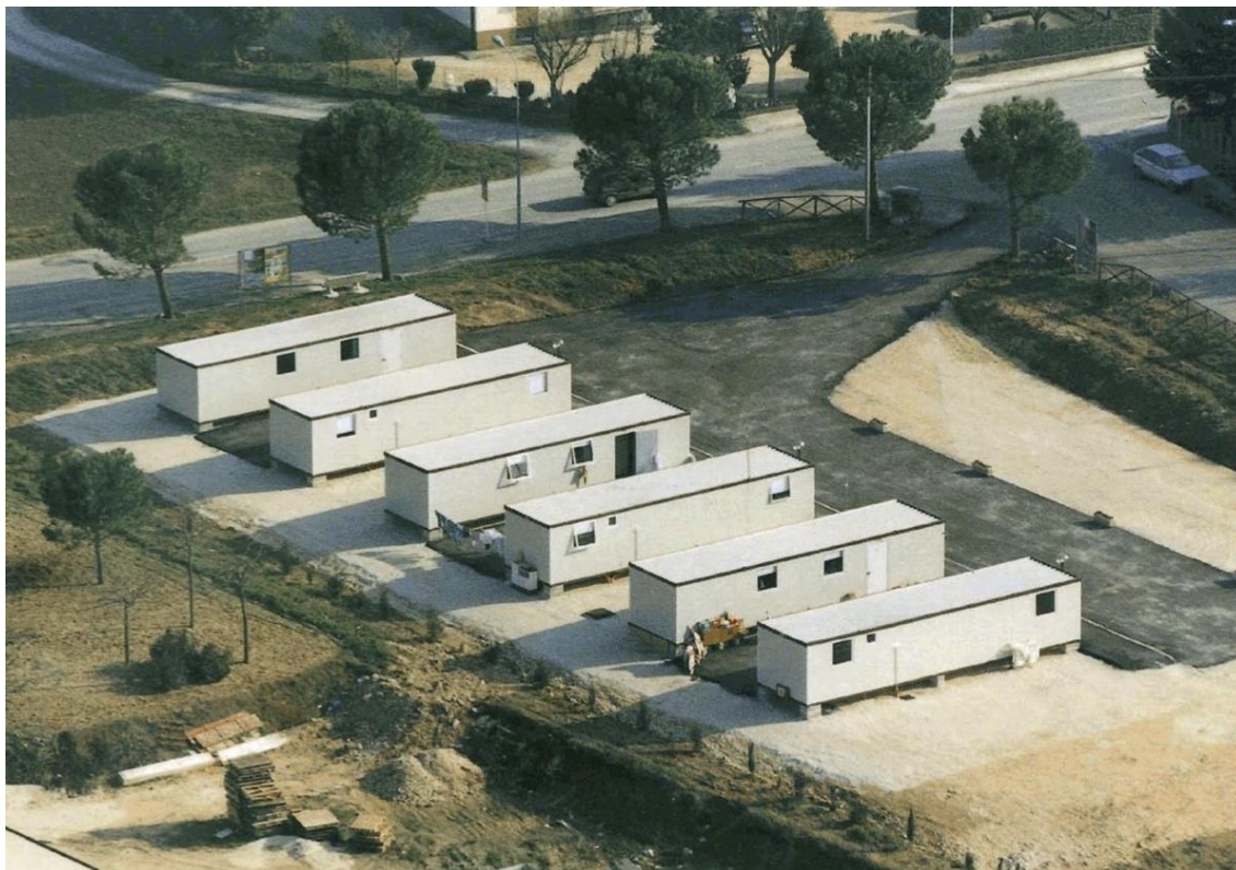
Figura 83. Container post-terremoto del 1997.
