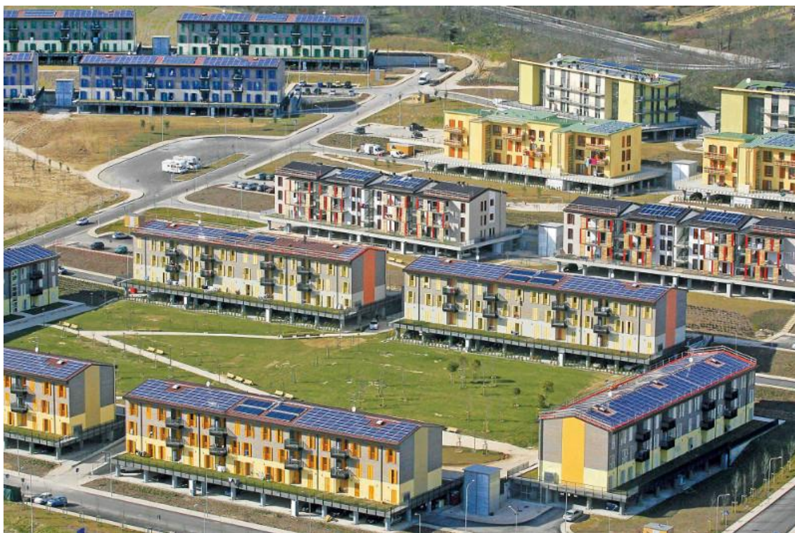
Figura 56. Bazzano, frazione de L'Aquila. Nuovo quartiere formato da edifici in linea su piattaforme con isolatori sismici, progetto CASE.
