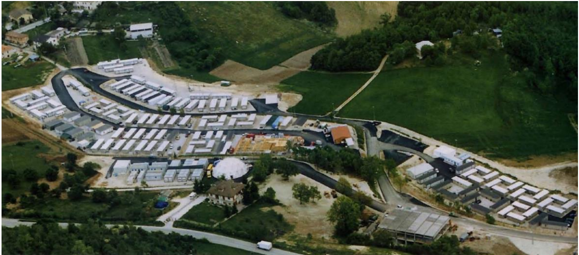
Figura 50. Villamagina, Sellano (PG) dopo il terremoto.
