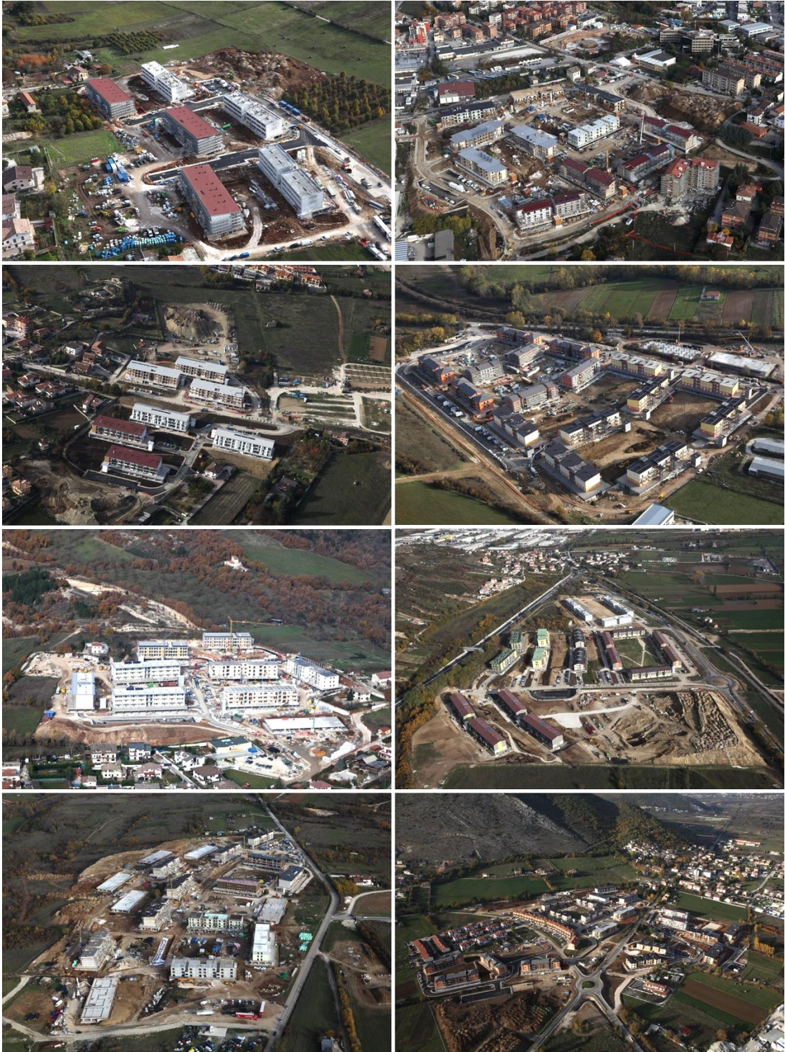
Figura 54. Aree progetto CASE nelle frazioni attorno L'Aquila. Dall'alto verso il basso e da sinistra verso destra: Roio, Sant'Antonio, Sant'Elia, Sassa, Tempera, Bazzano, Coppito, Cese di Preturo.
