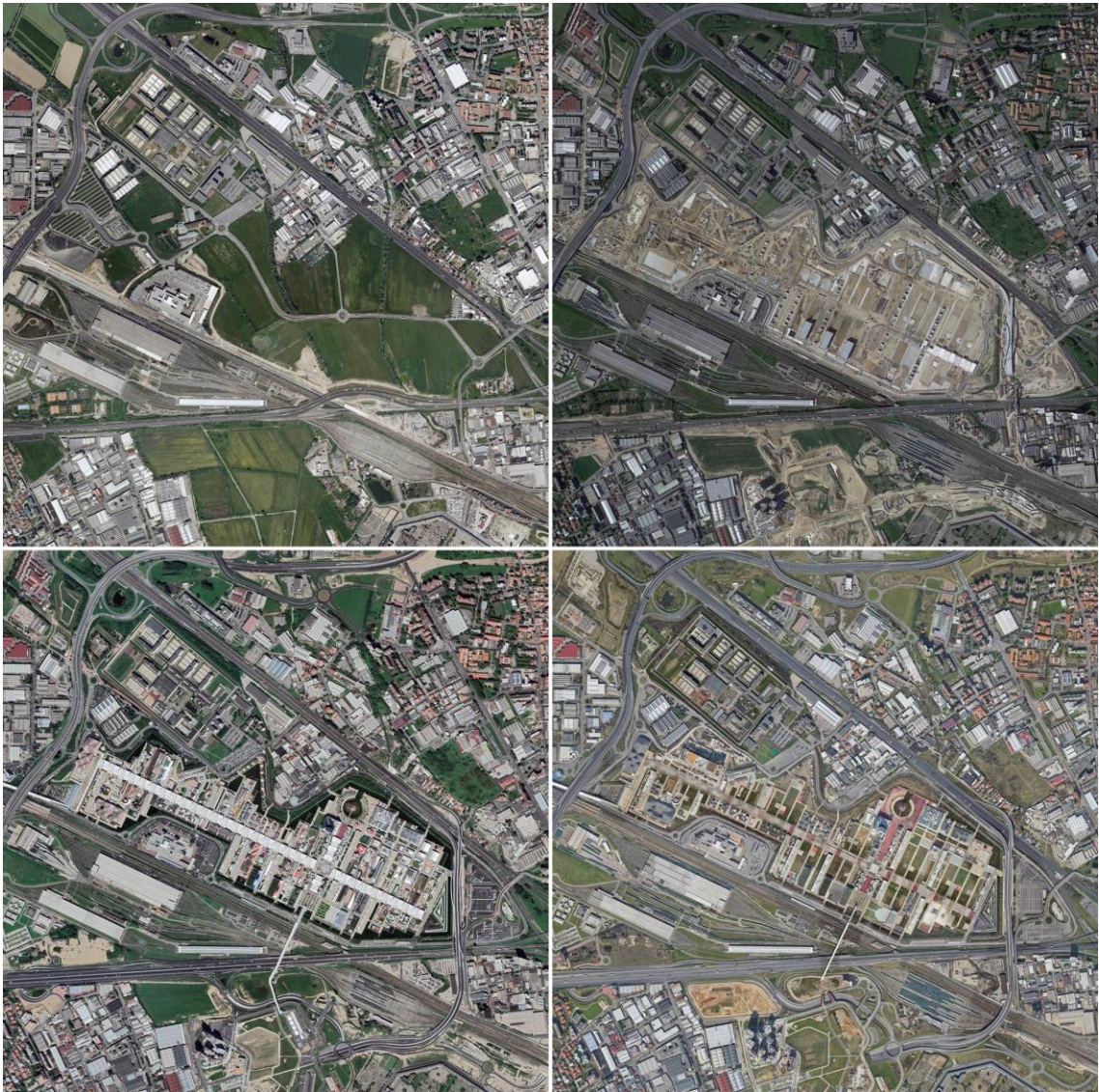
Figura 174. EXPO 2005 a Milano. L'area prima dell'Expo (luglio 2008), durante gli scavi per le fondazioni (aprile 2014), durante l'EXPO (settembre 2015) e oggi con ancora visibili i resti delle infrastrutture di supporto all'evento.
