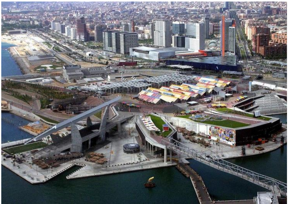
Figura 246. Vista dell'Esplanada con in evidenza lo spessore del suolo infrastrutturato.
