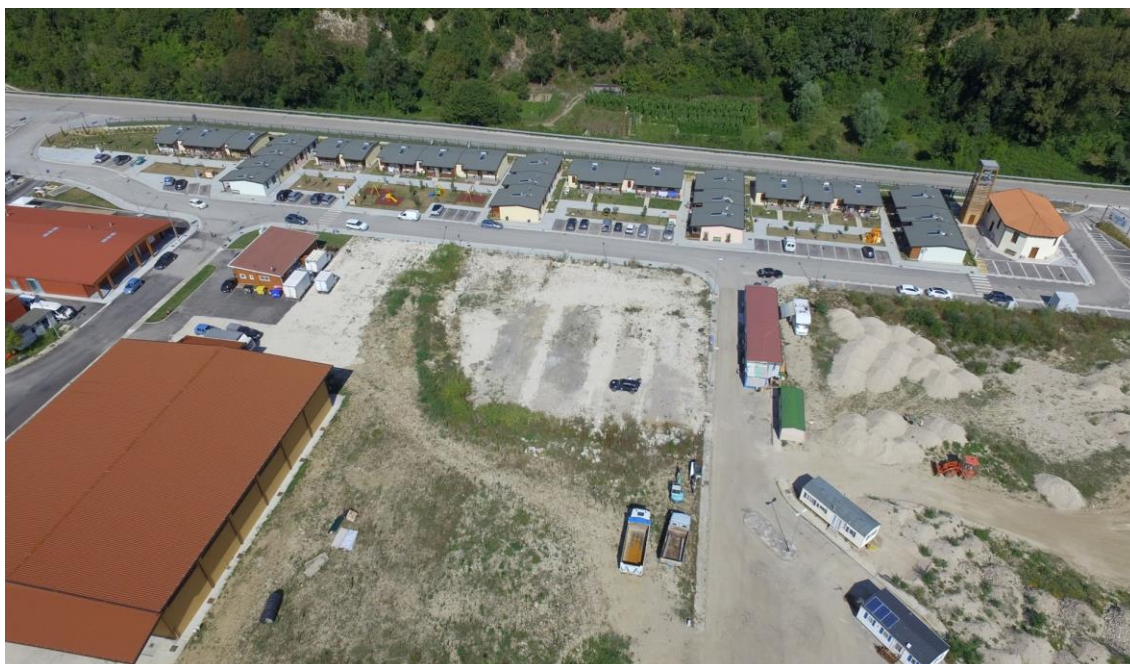
Figura 85. Vista aerea dell'insediamento temporaneo di "Pescara Del Tronto", totale Numero SAE: 26.
