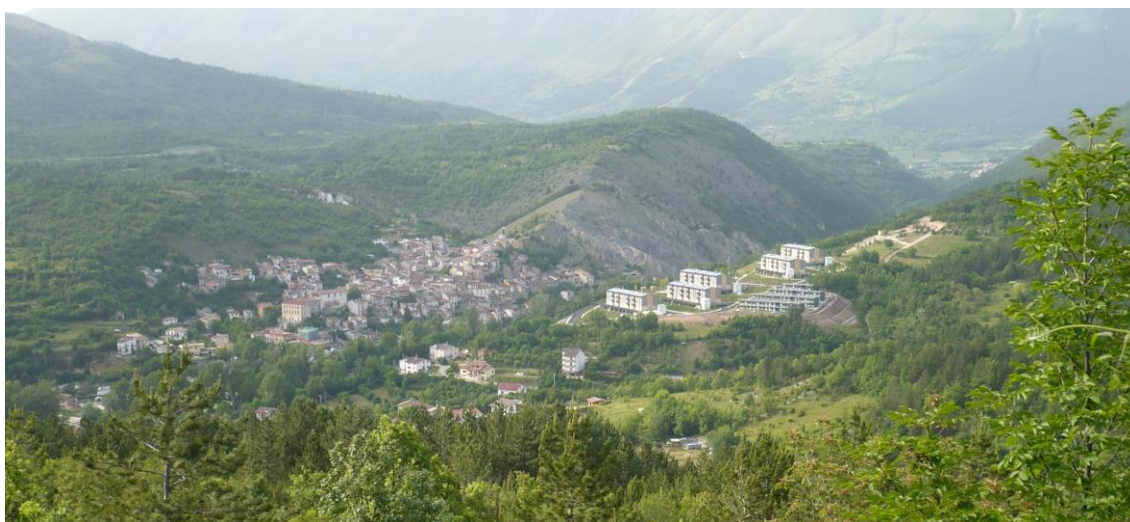
Figura 57. Camarda, frazione de L'Aquila. A sinistra il paese vecchio e a destra i cinque edifici in linea del progetto CASE.
