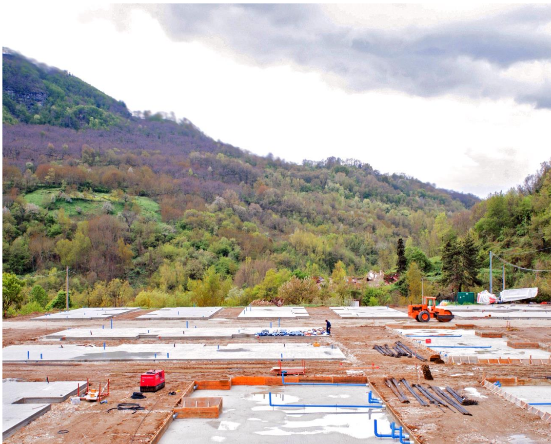
Figura 2. Cantiere SAE, Arquata del Tronto. Ph: Antonio Di Cecco, aprile 2017.
