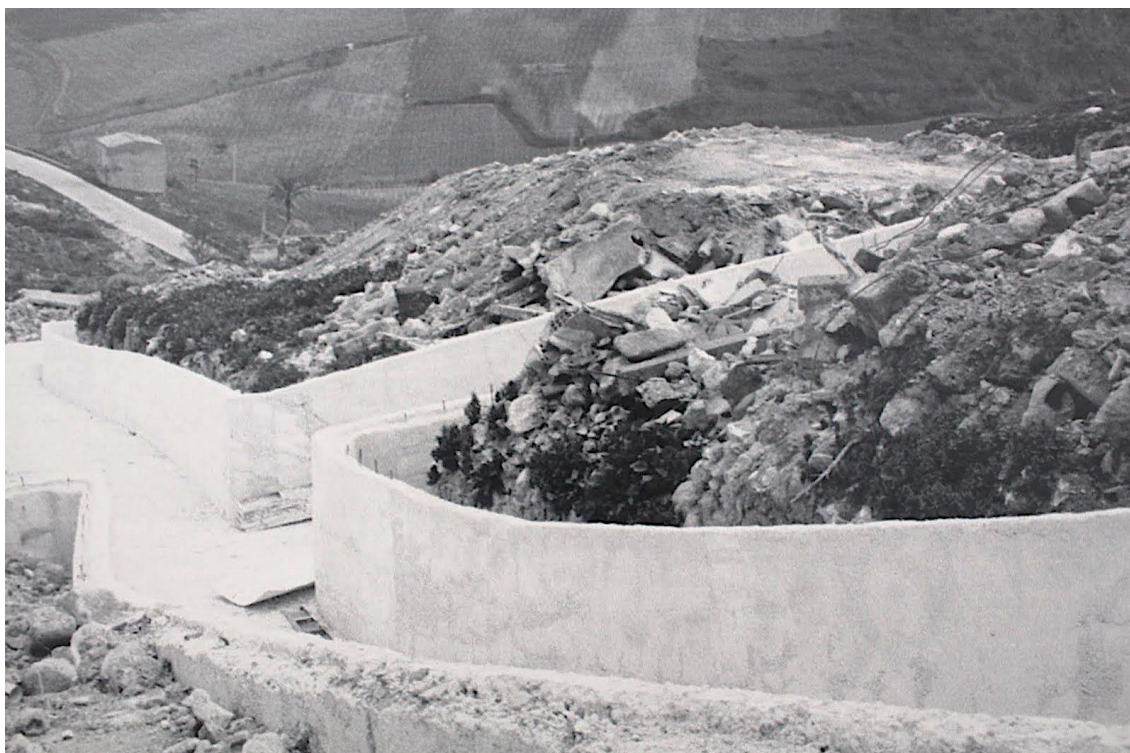
Figura 17. La costruzione del grande Cretto di Alberto Burri contenente le macerie di Gibellina vecchia.
