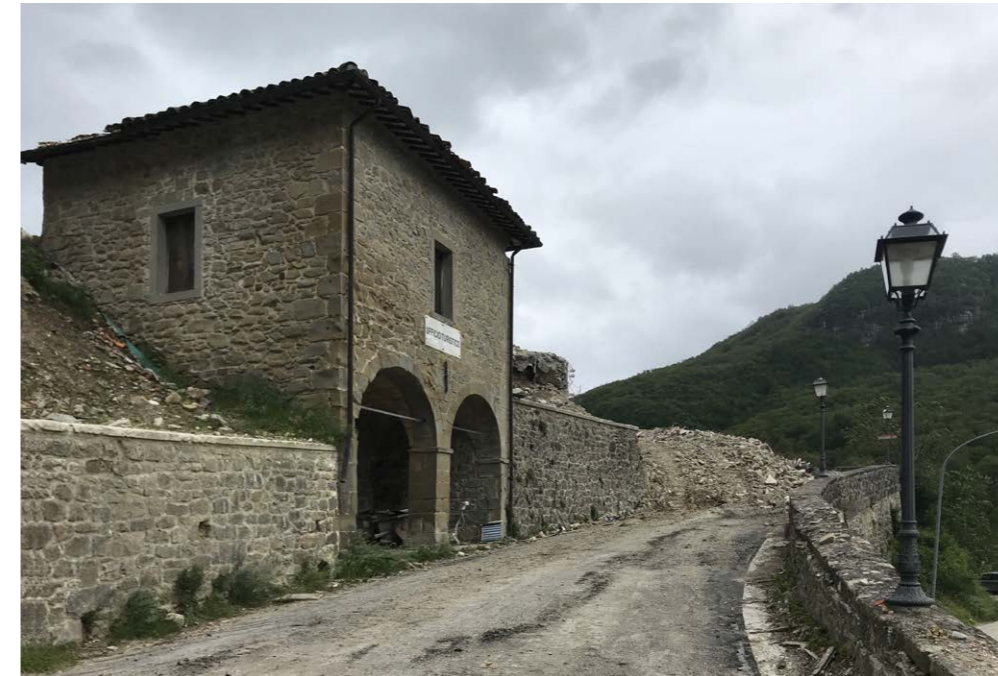
Figura 4. La calle de acceso a Arquata del Tronto y la presencia de la Oficina de Turismo, único edificio sobreviviente al terremoto. Fuente: Foto de los autores.
