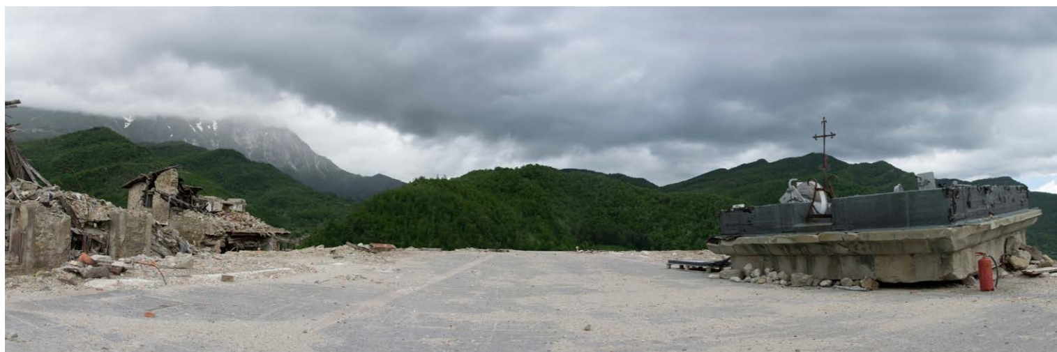
Figura 5. Arquata del Tronto: comparación entre fotos satelitales 2017-2024. Fuente: Google Earth. | Figura 6. La plaza de Arquata del Tronto post sismo: El terraplén, 2018. Fuente: foto de Luca Roselli.
