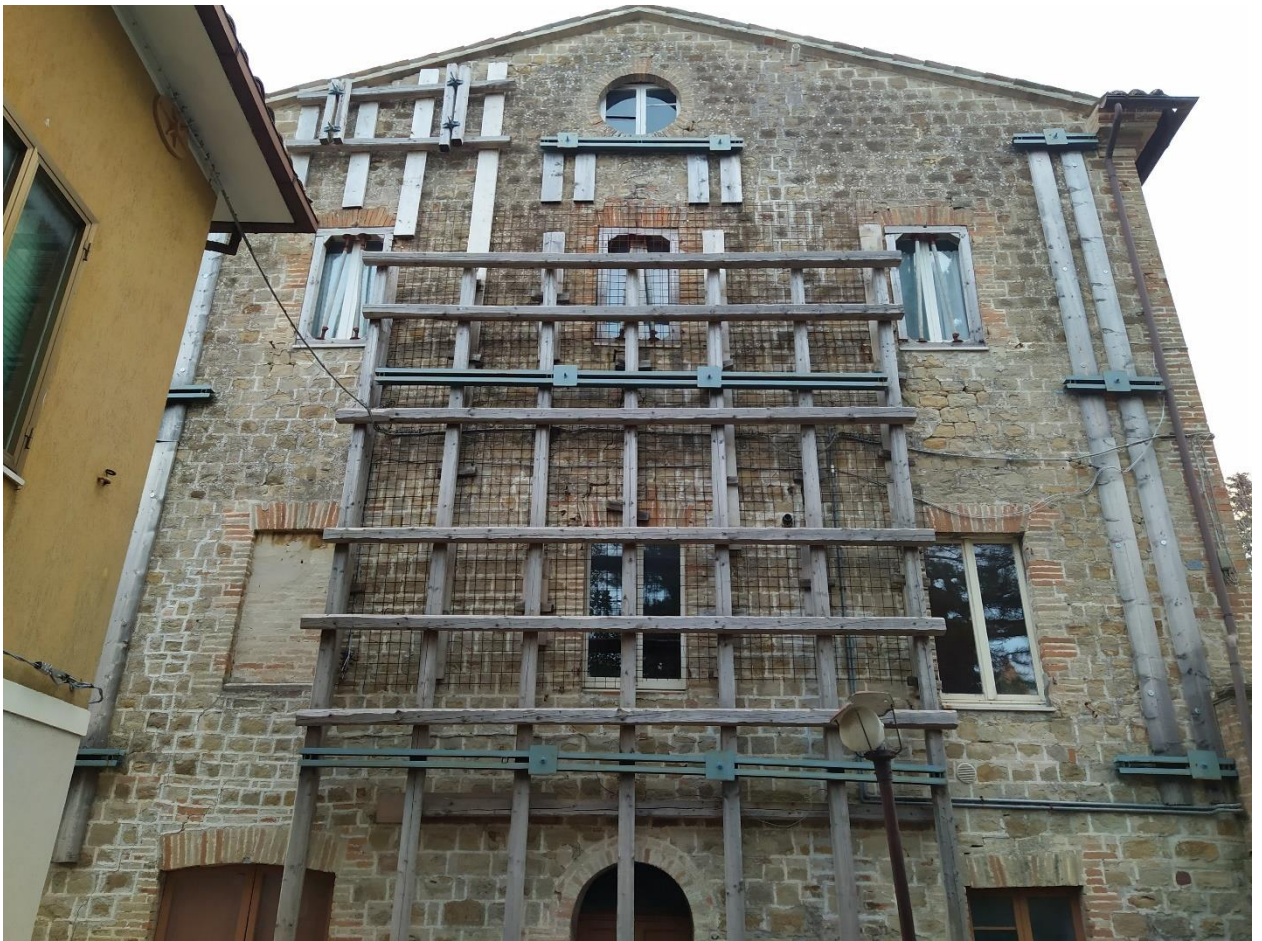
Figura 51 – Foto della struttura di messa in sicurezza di Palazzo Mochi
