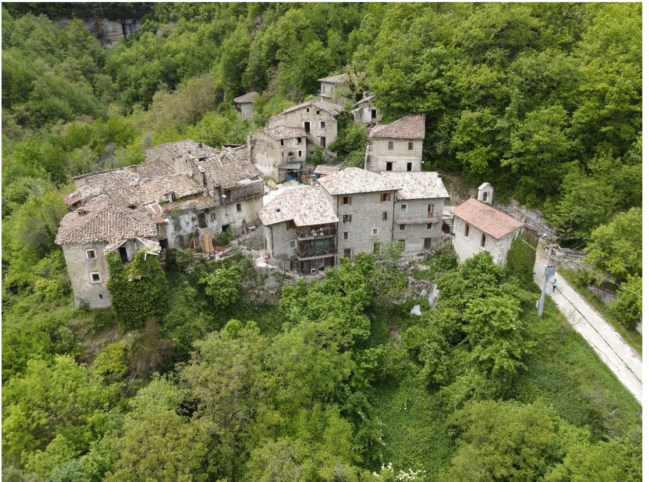
Figura 66 - Foto da drone di Frazione Vallecchia Monte Acuto
