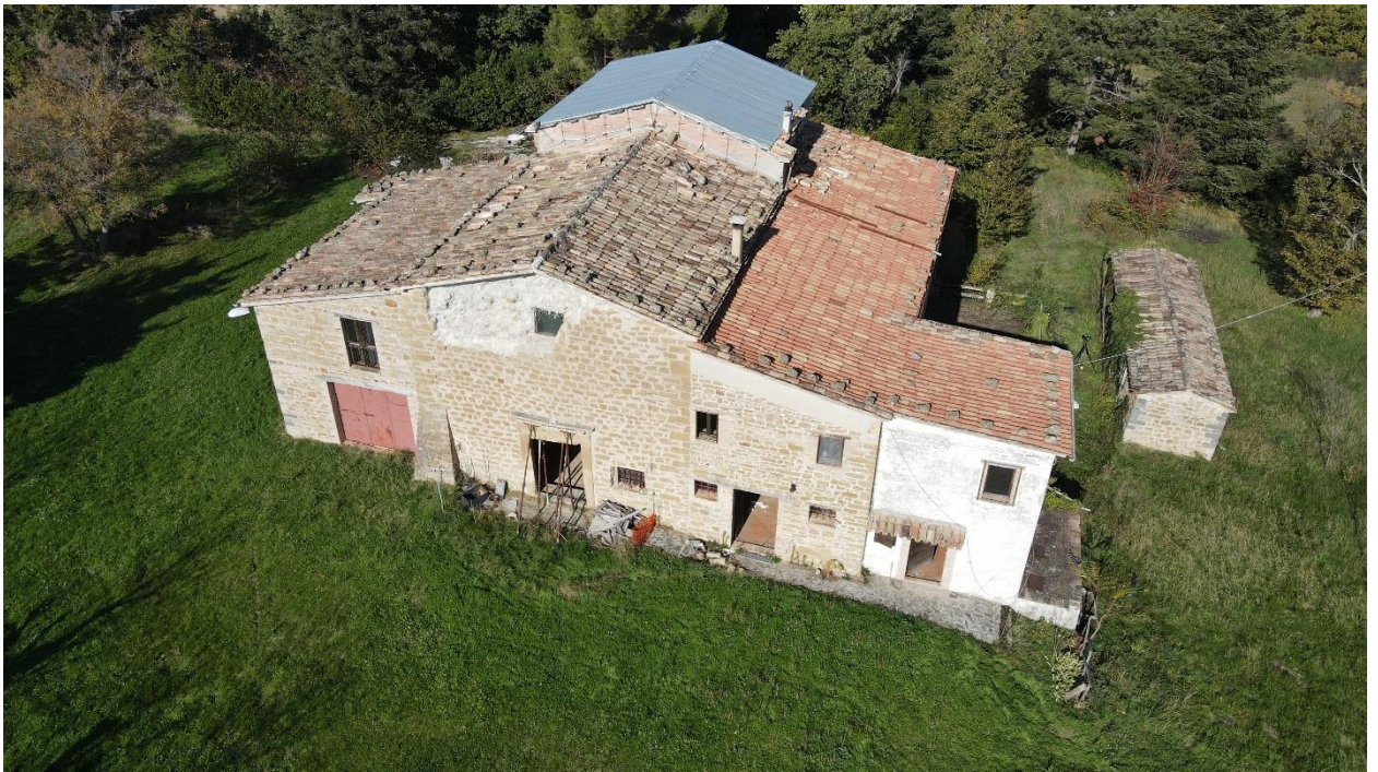
Figura 39 - Foto da drone della Chiesa di S. Maria di Garufo
