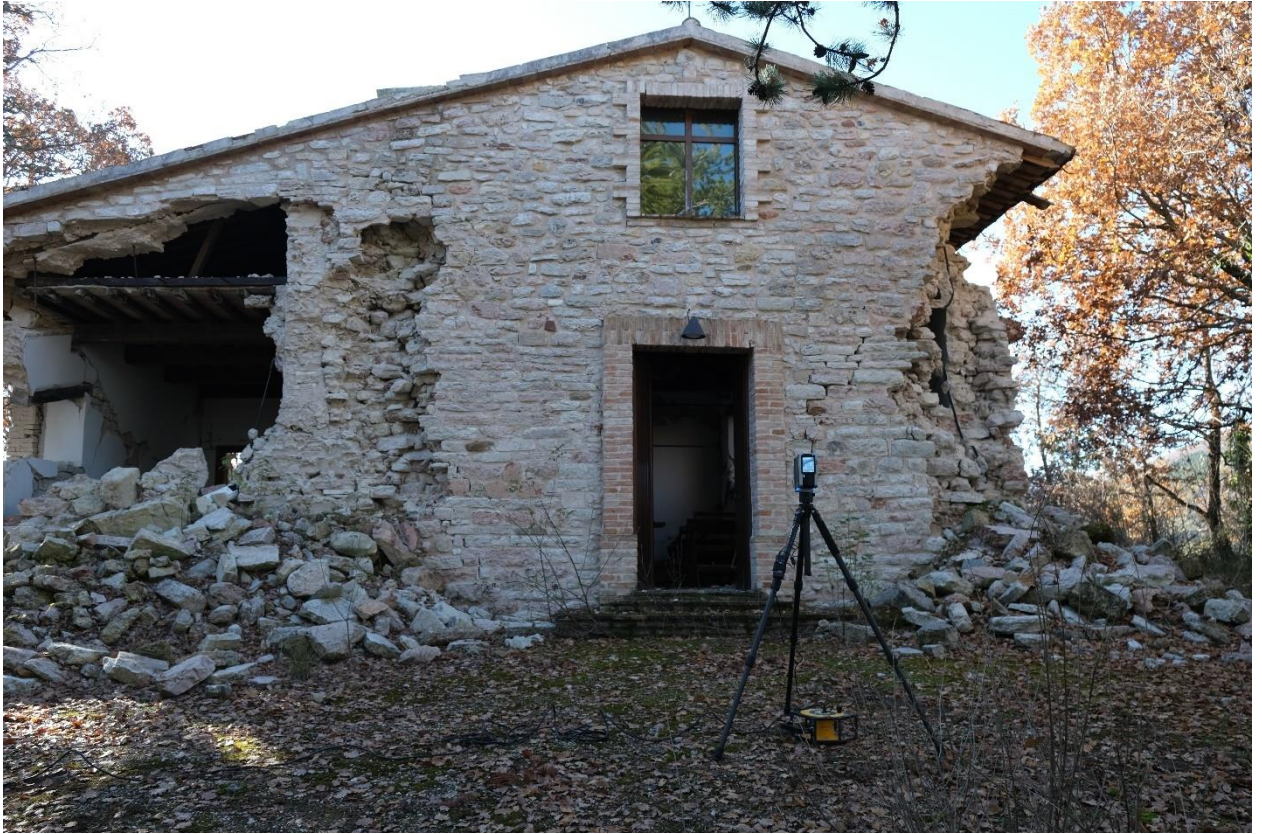
Figura 76 - Ripresa fotografica della Chiesa S.Andrea durante il rilevamento con il laser scanner Faro Focus X 130
