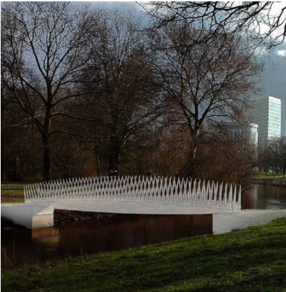
fig. 12 Eindhoven, ponte in composito fibrorinforzato con lino e canapa, 2016
