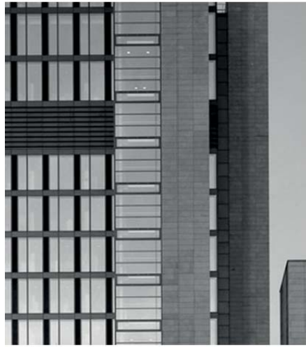
Debitel. Stuttgart RKW Architektur + Stadtebau. 2002
