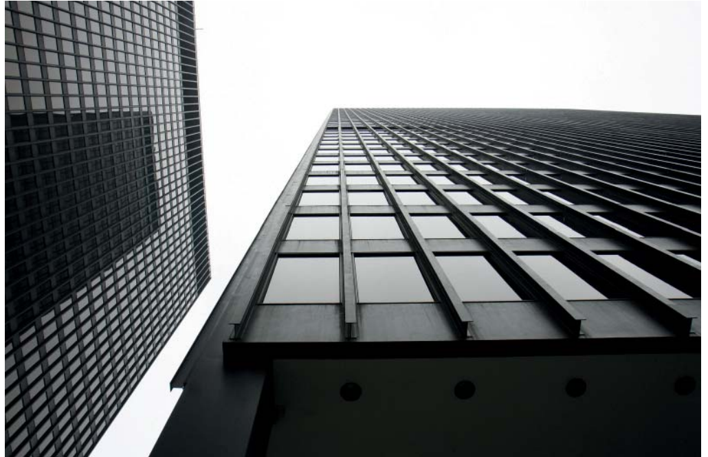
Figura 8. Dettaglio della facciata del Seagram Building, Ludwig Mies van der Rohe e Philip Johnson, New York, 1958
