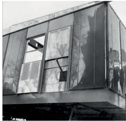
Figura 2. Dettaglio del sistema di apertura dei pannelli di facciata, Maison Métropole, Jean Prouvé, 1949
