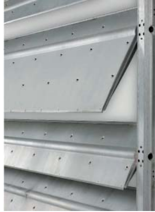
Figura 5. Dettaglio del sistema di frangisole in alluminio per l'Hotel de France, Jean Prouvé, Guinea, 1953
