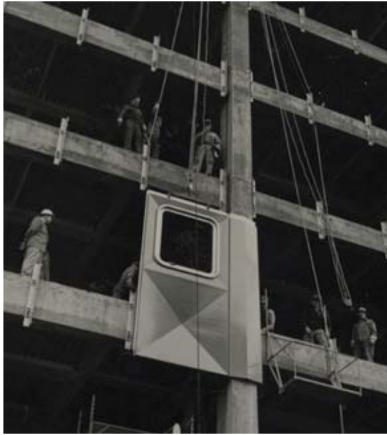
Figura 8. Installazione del primo di rivestimento modulare sull'edificio di Alcoa. 1953
