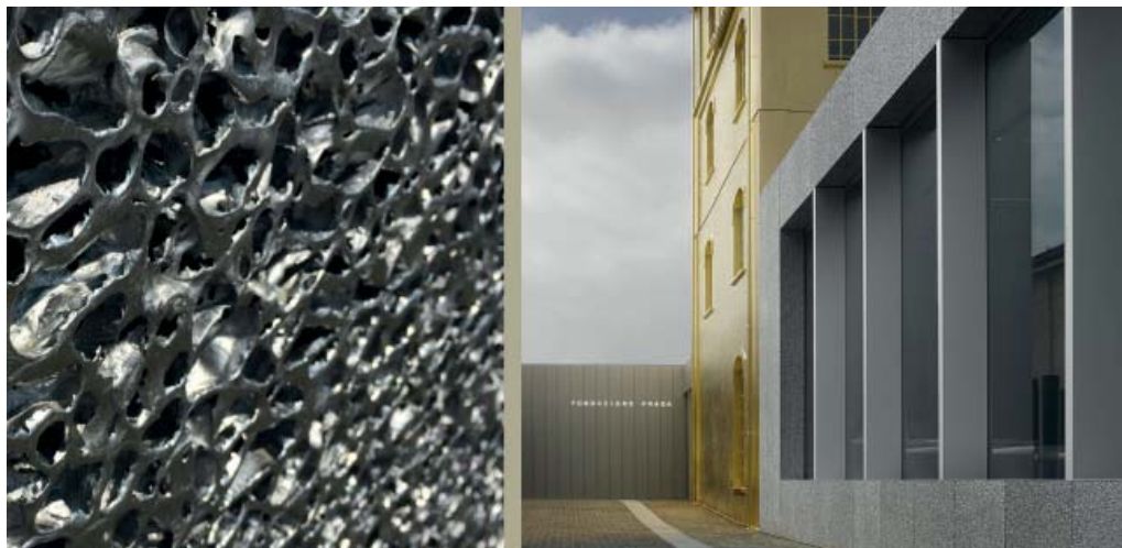
Figura 5. Applicazione della Schiuma di Aluminio Alusion sulla facciata di Fondazione Prada, Milano, Studio OMA, 2015
