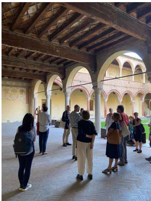
2: Il loggiato di Casa Romei, realizzato con l'impiego di travi composte (foto di Riccardo Fattori)
