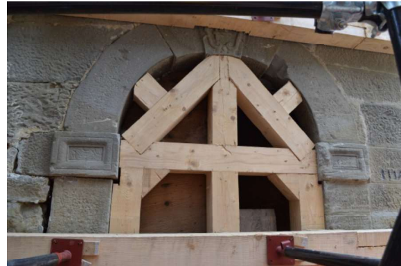
Fig. 2. Puntellamento dell'arco con centinatura lignea.
