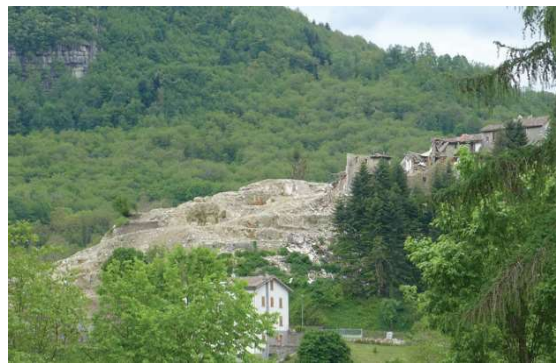
Fig. 8. Recente immagine di Arquata del Tronto, ormai completamente demolita.
