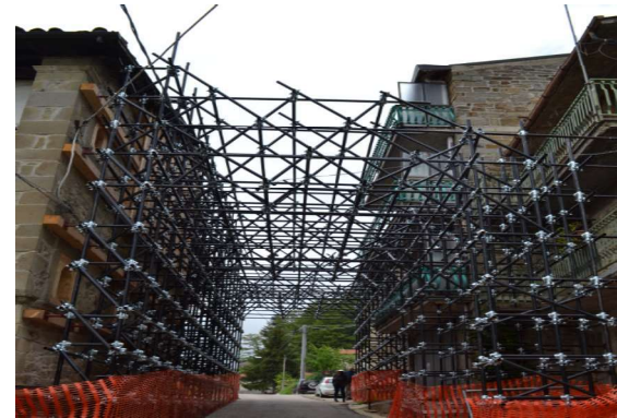
Fig. 3. Puntellamento di contrasto tra due edifici.
