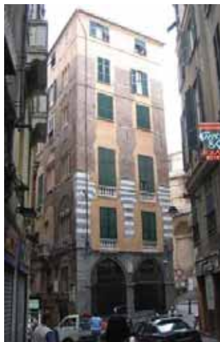
Fig. 04 : Gênes, rue San Siro, maison médiévale avec loggia transformée à l'âge moderne et récupérée par restauration avec débadigeonnage des parties enduites. Fig. 05 : dessin joint à une demande de construction de balcons surplombant en remplacement de la saillie médiévale (Archives historiques de la Commune de Gênes, Actes des Pères de la Commune, 81/144, 29/7/1619)
